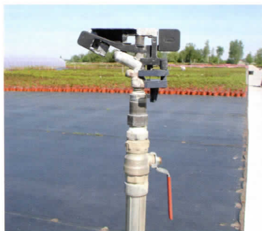
Fot. 11. Zawór kulowy pod zraszaczem pozwala na wyłączenie podlewania na wybranych kwaterach
