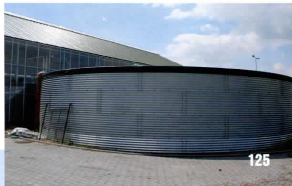
Fot. 13. Zbiornik przy szklarni, do gromadzenia wody deszczowej
