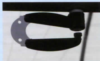
Fot. 3. Zraszacz z blaszką, która zapobiega skapywaniu wody
