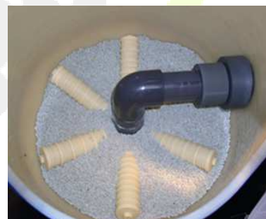
Fot. 25. Sączki umieszczone na dnie filtra piaskowego
