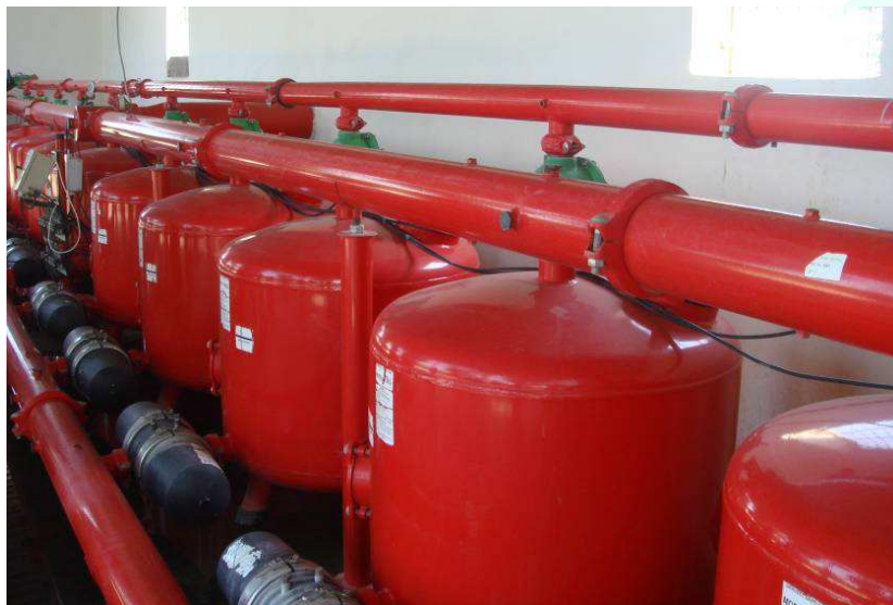
Fot. 25 Zestaw filtrów piaskowych i dyskowych
