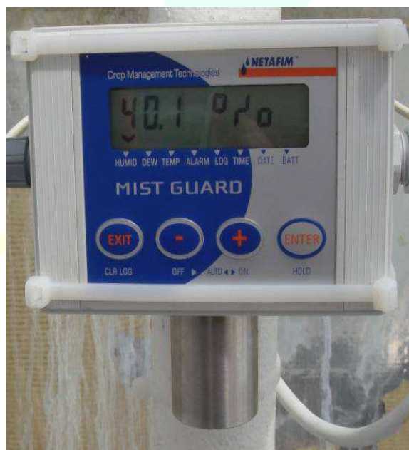
Fot. 32. Sterownik nawodnieniowy wyposażony w czujnik pomiaru temperatury i wilgotności powietrza
