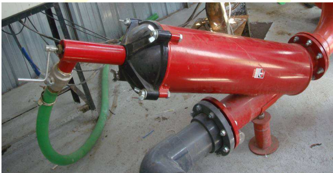
Fot. 19. Filtr siatkowy wyposażony w „ręczny” system oczyszczania
