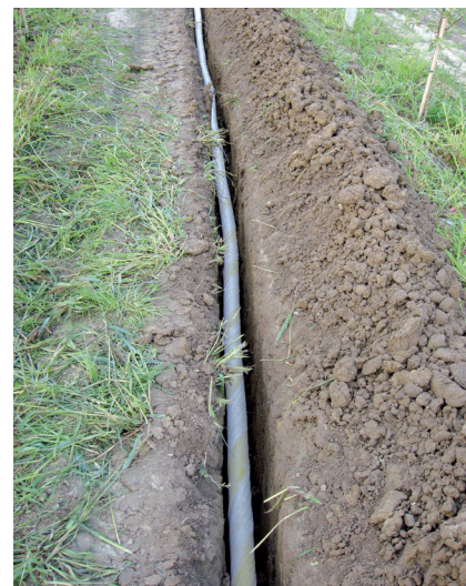
Rury drenarskie (o średnicy 5–10 cm) układa się na głębokości około 40–150 cm
