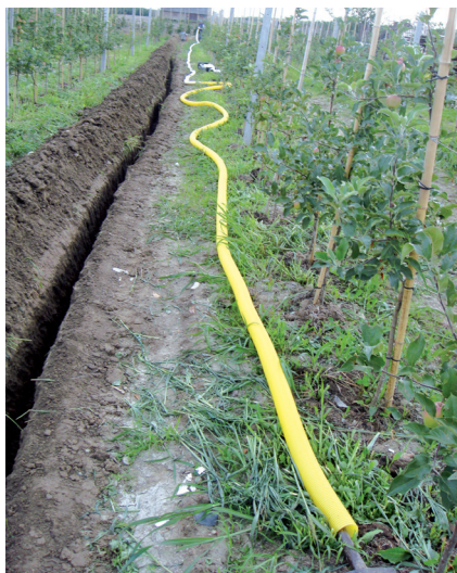
Elementy niezbędne do wykonania drenażu podziemnego: rury drenarskie z PVC w otulinie i bez otulinie
