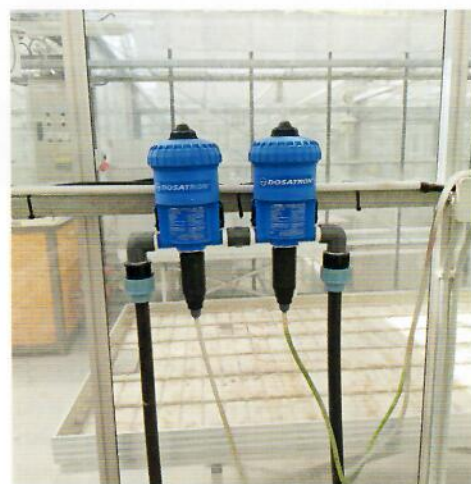
Fot. 4. Dozownik Dosatron często wykorzystywany do zarządzania fertygacją.
