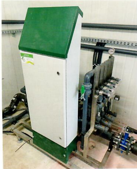
Fot. 5. Mikser nawozowy ułatwia fertygację.
