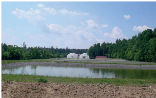
Fot. 15. Zbiorniki retencyjne zasilane wodą gruntową. (W. Treder)
