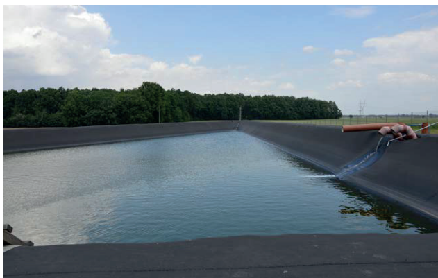
Fot. 14. Zbiornik do gromadzenia wody deszczowej spływającej z dachu szklarni. (W. Treder)
