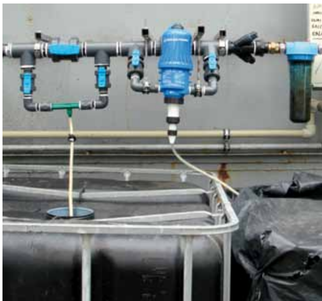
Fot. 7. Bocznikowe zamocowanie kolejno dwu dozowników — pompy proporcjonalnej i iniektora fot. 1, 2, 5, 7–9b. W. Treder
